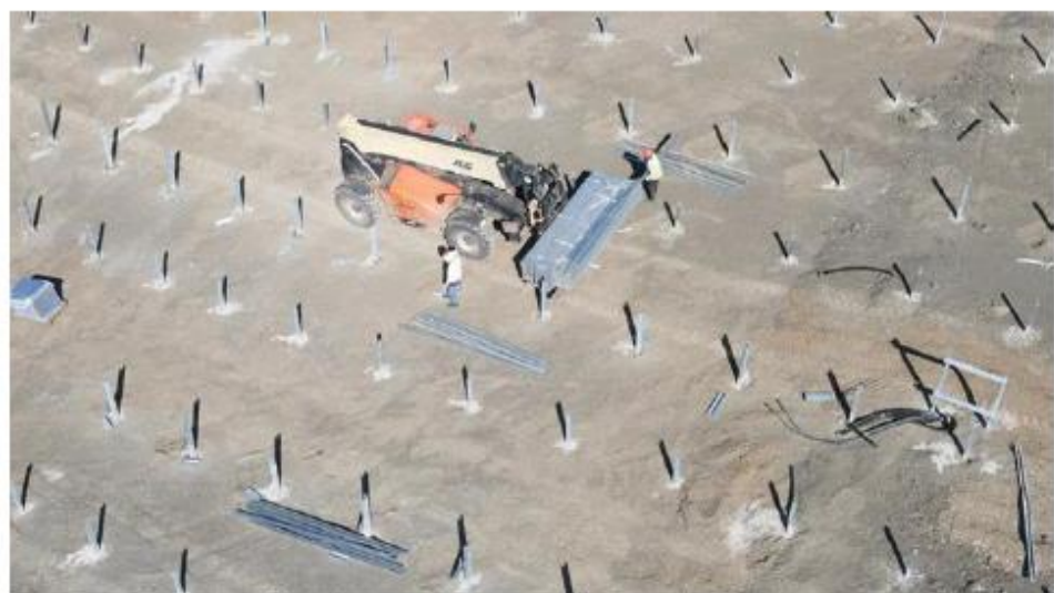
PII- PILLING WORKS
